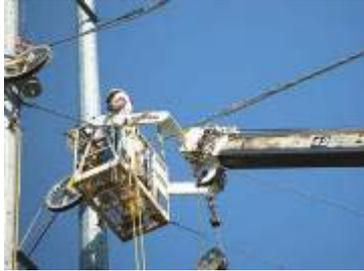
Figura 3: Alça preformada da PLP e Bandolas de 70 cm na estrutura.
