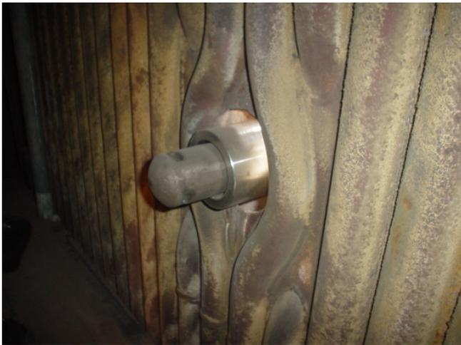
Figura 2. Soprador de vapor.
