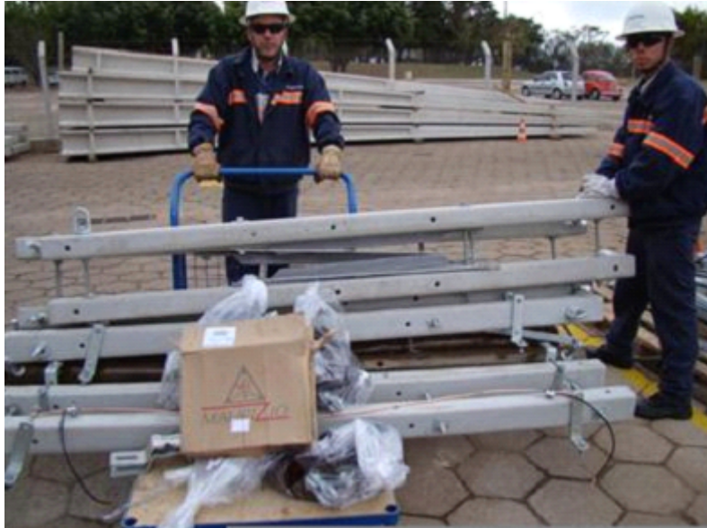
Figura 4 – Montagem prévia de estruturas
