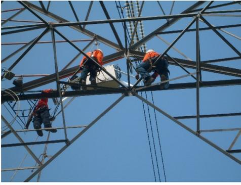
Figura 9 - Fixação do gabinete principal na torre.
