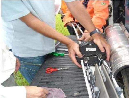
Figura 7 - Adaptação de cordão óptico na caixa de emenda principal.
