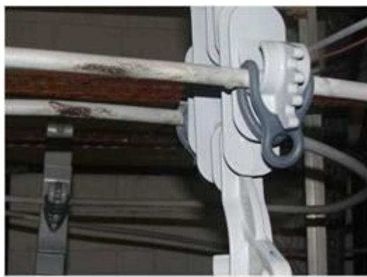
Figura 7 - Detalhe de trilhamento típico ocorrido no cabo em pontos fora da amarração
