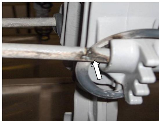
Figura 3 - Detalhe da erosão no cabo coberto
