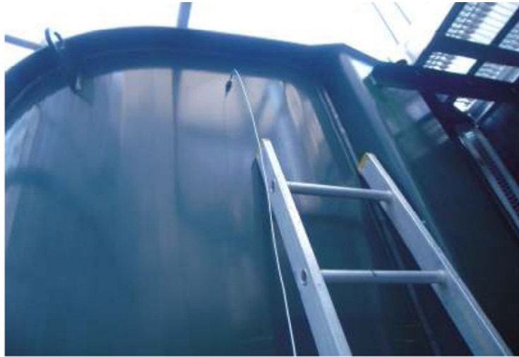
Figura 4 Instalación de los Pasadores (Studs)
