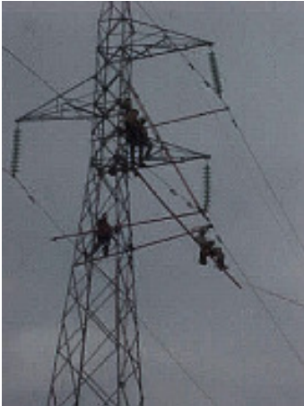
FOTO 2 - Início da instalação
