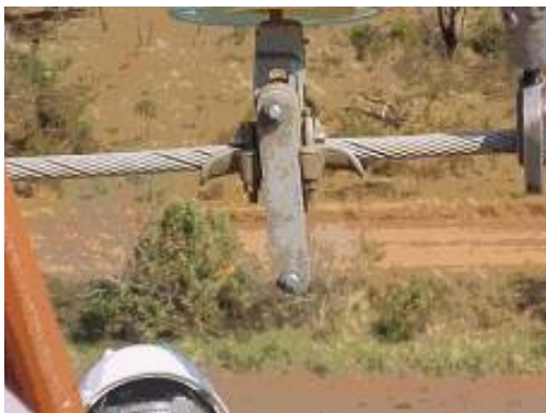
FOTO 3 - Instalação do extensor
