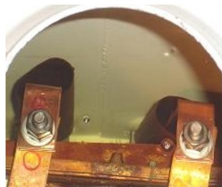
FIGURA 15 - DETALHE INTERNO DAS CONEXÕES ENTRE OS TERMINAIS DO ENROLAMENTO DE BAIXA TENSÃO
