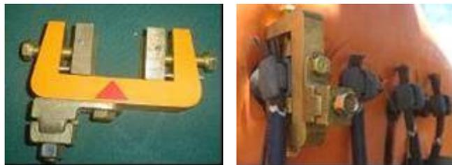
FIG. 8 – DISPOSITIVO DE ACOPLAMENTO DAS BUCHAS DE BAIXA TENSÃO, PARA CORRENTES DE ATÉ 400 A
