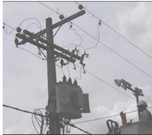
**FIG. 18 – TRANSFORMADOR DE DISTRIBUIÇÃO EM SUBSTITUIÇÃO**
