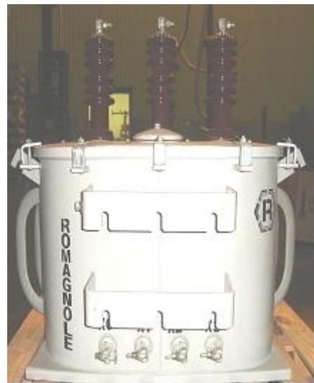
FIG. 14 - TRANSFORMADOR DE DISTRIBUIÇÃO COM AS BUCHAS DE BAIXA TENSÃO REPOSICIONADAS
