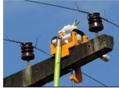
FIG. 2 – LANÇADOR DE CORDA-GUIA
