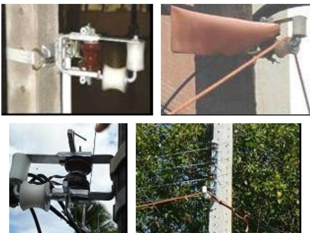
FIG. 6 – CARRETIHAS DE BAIXA TENSÃO DESENVOLVIDAS
