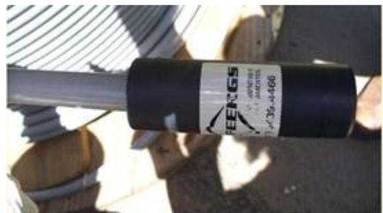
FIG. 4 – MUFLA TERMINAL PARA CABO PROTEGIDO DE 185 mm<sup>2</sup>
