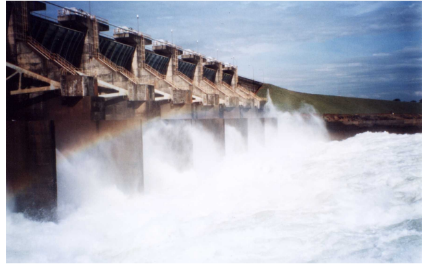
Figura 5 - Ressonho hidráulico formado no Protótipo da UHE de Porto Colômbia (vazão de 4000 m³/s).
