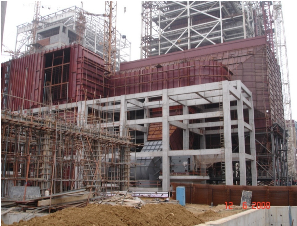
Figura 2 – Aspecto de obra de termelétrica na China
