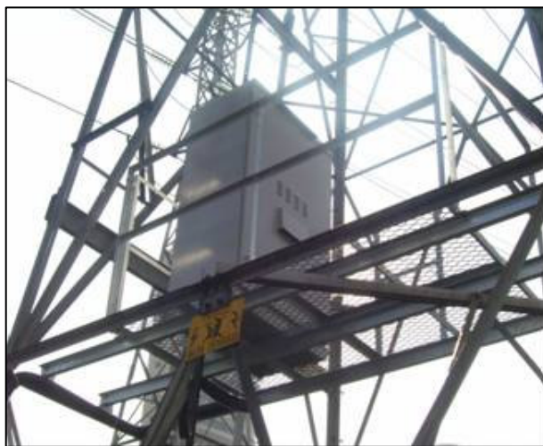
Figura2: Painel e Plataforma de estrutura metálica
