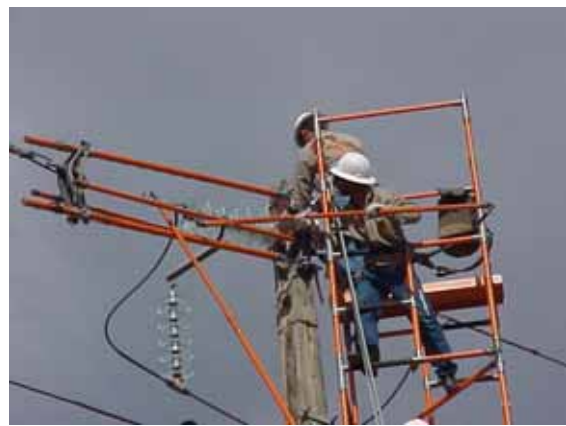
Figura 16 – Instalação da nova Cadeia de isoladores
