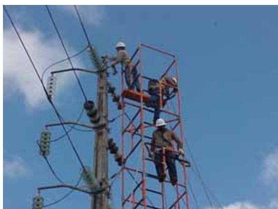
Figura 03 – Instalação do jugo lado morto
