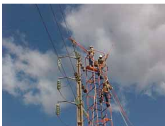
Figura 06 – Instalação do berço
