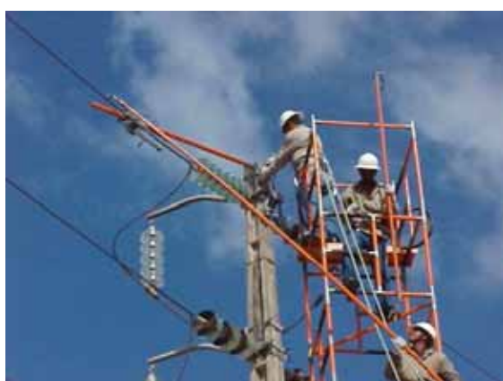
Figura 05 – Instalação do camelongo
