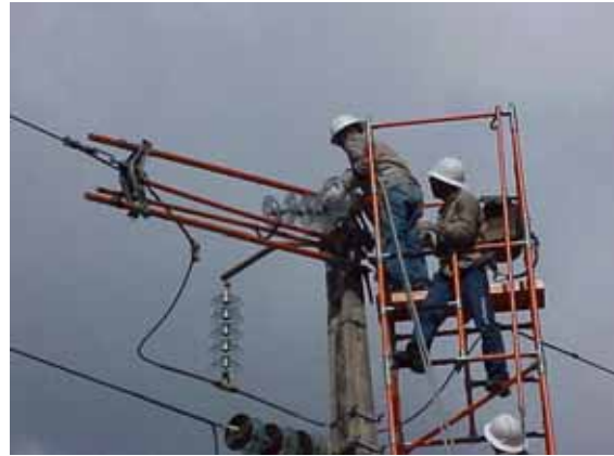
Figura 14 – Instalação da nova cadeia de isoladores
