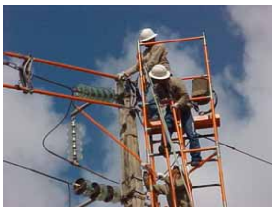
Figura 10 – Instalação do Berço e retângulo de força
