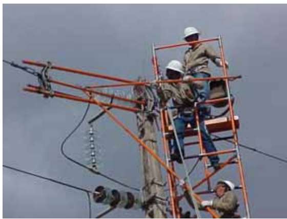
Figura 15 – Instalação da nova cadeia de Isoladores
