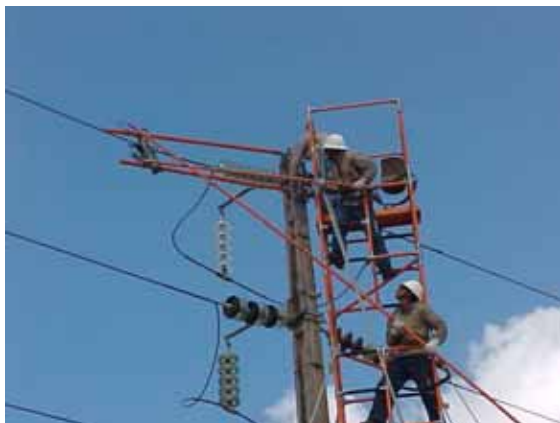
Figura 07 – Instalação do Berço
