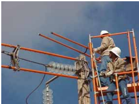
Figura 17 – Cadeia nova de Isoladores instalada
