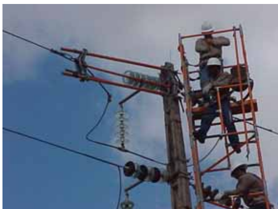
Figura 11 – Conclusão instalação do berço e retângulo de força
