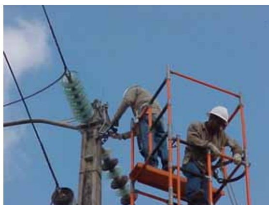
Figura 04 – Instalação jugo lado Morto
