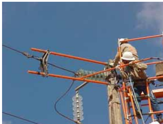
Figura 08 – Instalação do Berço
