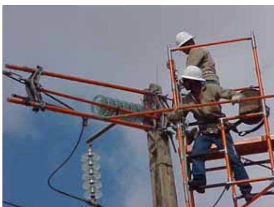
Figura 09 – Instalação do Berço e Retângulo de força
