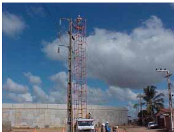
Figura 02 – Montagem do Andaime
