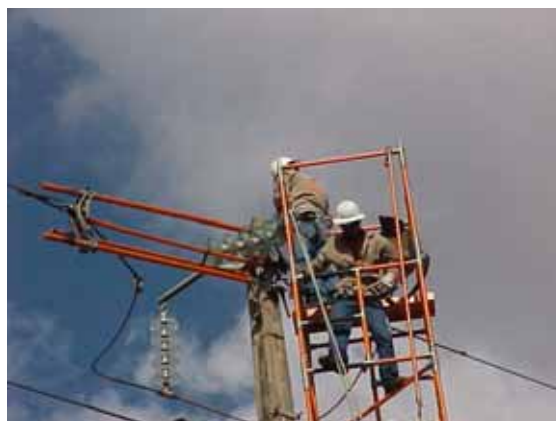
Figura 12 – Retirada da cadeia de isoladores danificada.
