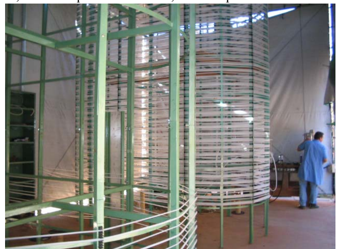
Foto 5. Estrutura suporte dos tubos das células de recalque.
