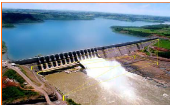
Figura 4 – Disposição dos pontos da rede externa de monitoramento.
