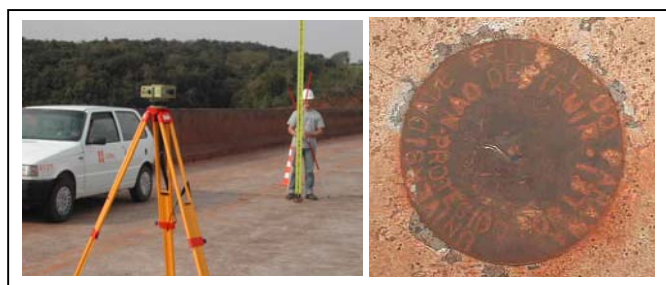
Figura 3 – Execução do nivelamento geométrico de primeira ordem
