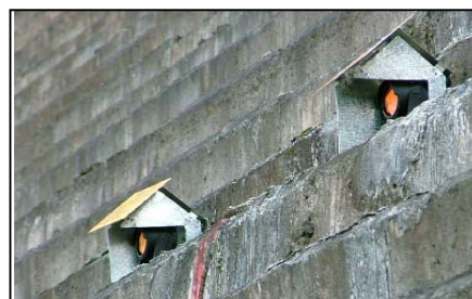
Figura 6 – Proteção para os prismas na face a jusante da barragem.
