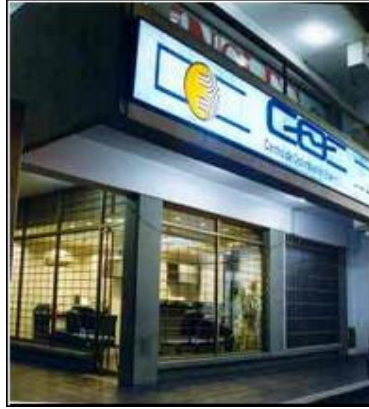
Anexo 1 - Foto del Centro de optimización Energética de ENELVEN
