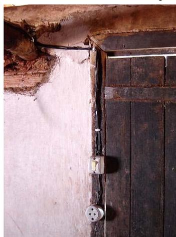
Foto 6 - Kit Bico de Luz Instalado nas Residências
