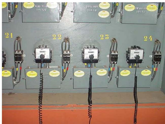
Foto 8. Medidores Eletrônicos Instalados no Edifício Piloto.
