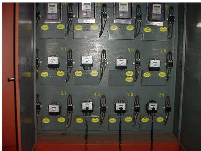
Foto 7. Medidores Eletrônicos Instalados no Edifício Piloto.
