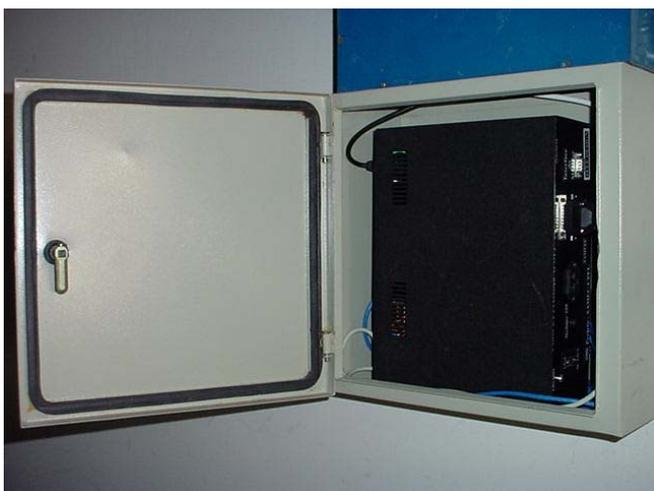
Foto 10. Ponto de Presença Instalado no Edifício Piloto.
