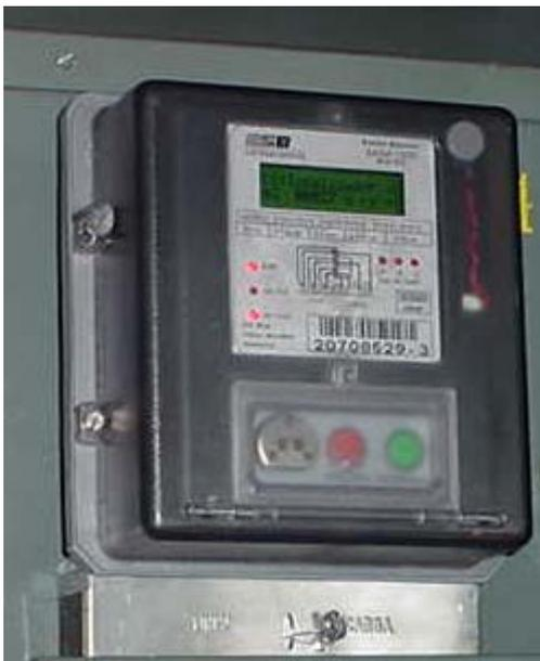
Foto 1. Medidor Eletrônico de Energia.
