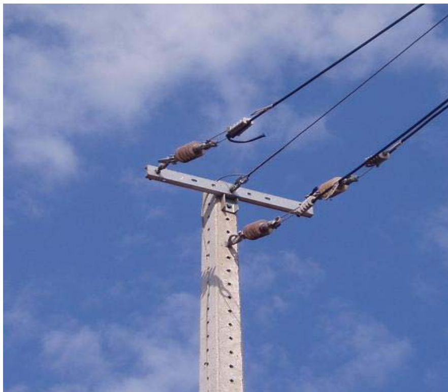
Figura VIII – Cruzetas em perfil U e Fixador U
