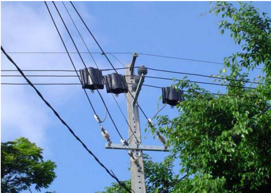
Figura I – Protetor para Grampo e Estribo de Linha Viva.
