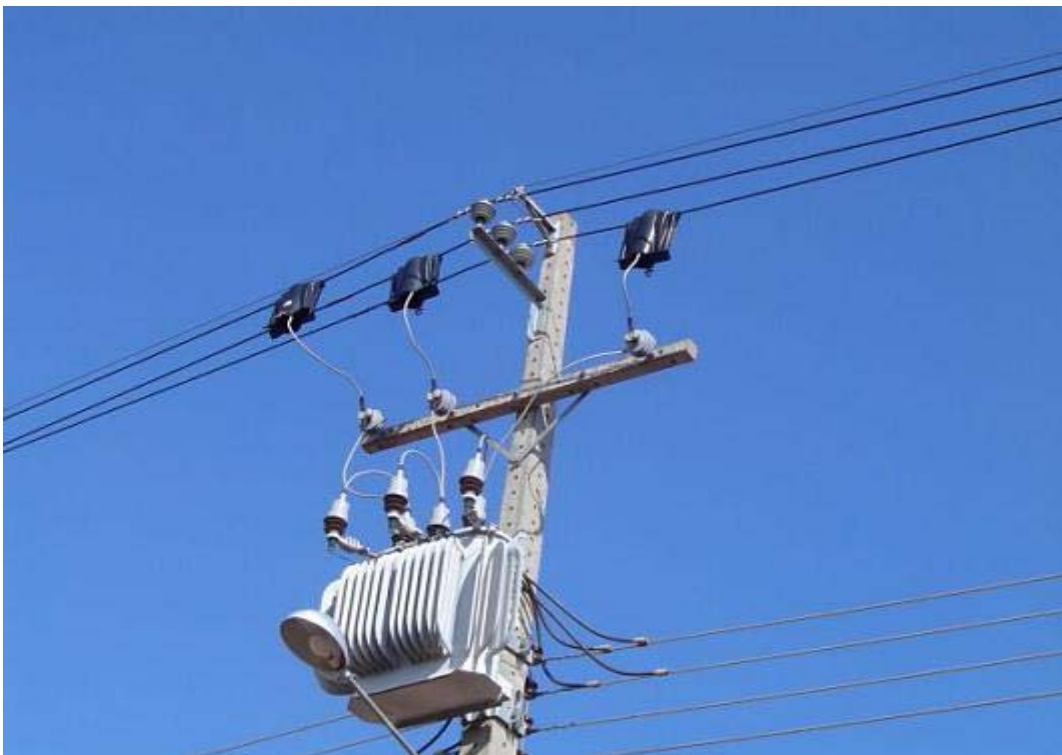
Figura II – Cobertura para isolamento
