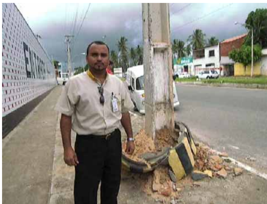
Figura 5 – Constatação da Atuação das Defensas
